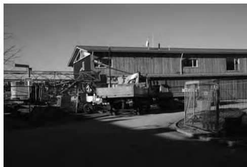
Baustelle für die Erweiterung der Käthe-Kruse-Kindertagesstätte
