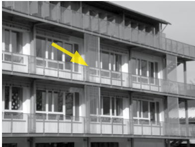
An den Geländern der neuen Fluchtbalkone sollen Solarzellen montiert werden
